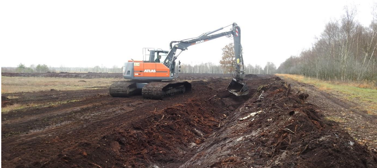
Abb. 3: Graben(teil)verfüllung
