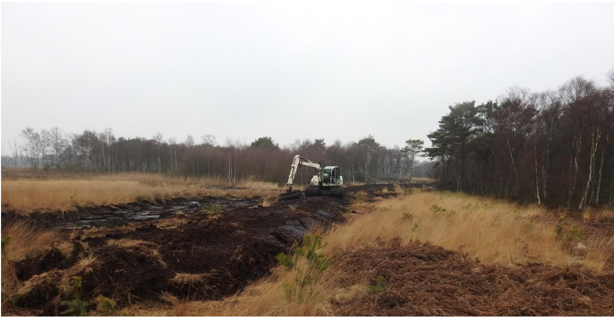
Abb. 2: Erstellen einer Verwallung
