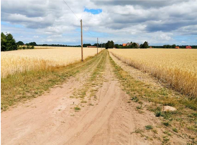
Abb. 11 Ausbau unbefestigter Erdwege zu Schotterwegen (E-Nr. 4: Der Weg wird ausgekoffert und geschottert. Durch eine Verbreiterung erhält er beidseitig ca. 1,5 m breite Randstreifen).
