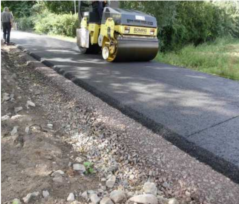
Abb. 5 Wegebau: Bitumen-Decke (Quelle: Arl-Leine Weser, Information zur Flurbereinigung, Wegebau – Standardbauweisen)
